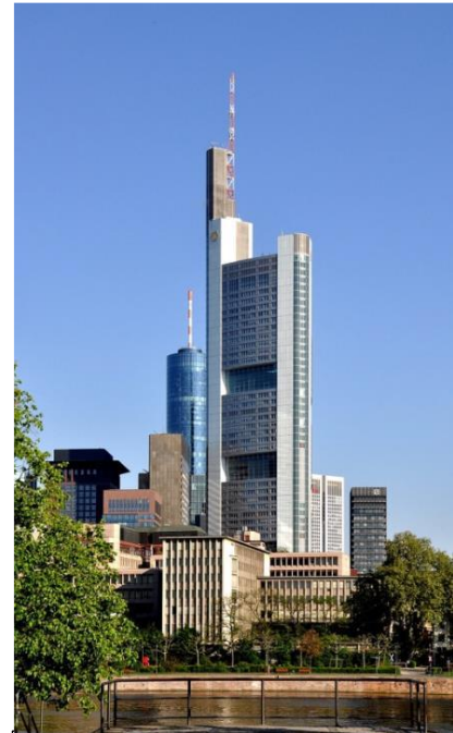
Commerzbank Tower, Kaiserstraße 16, 60311 Frankfurt am Main
